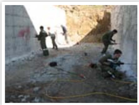
Die Sprengbefugten des Bezirkes trafen sich zu einer Sprengübung in Schönegg. Ein Fahrsilo war zu sprengen. Unsere Sprengexperten Höfler Rudolf und Pröll Andreas waren mit von der Partie. 35 kg Sprengstoff in 477 Ladungen ließen schließlich die Betonwände einstürzen.
